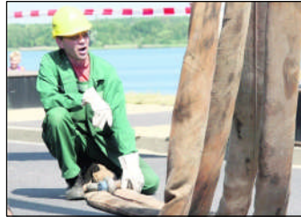
Ein Arbeiter überprüft die am Kran hängenden Rundschlingen, ehe die an dem Schiff befestigt werden.
