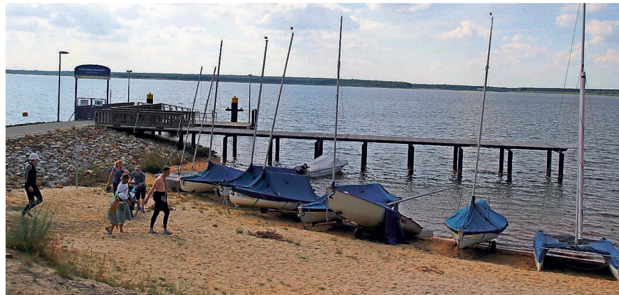
Blick auf den Bootssteg des Schiffsanlegers. Dieser soll noch ertüchtigt werden.
